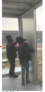
将墙板推入柱内
