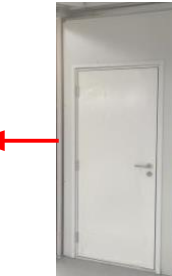
在门洞内侧安装大门，用六角内六角钻钉(5.5*75)钻出尾端线固定门和支架。
