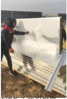
去掉墙板上的保护膜
