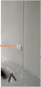
最后，用干墙钉（钉子）将电器插座固定在墙板上。
