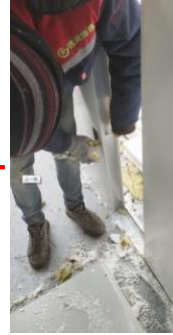
在墙板的正面和侧面距地面400mm处开孔，预留电器插座线路
