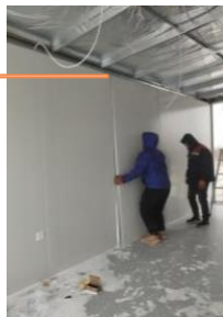
用同样的安装方法分别安装其他墙板，用六角钻尾钉（5.5*100）将梁和墙板固定在顶部（屋顶）
