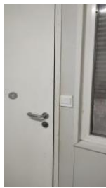
在墙板上预留电器开关线，完成开关板的安装
