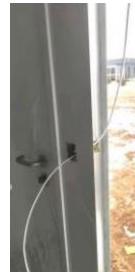
在墙板上预留电器开关线，完成开关板的安装
