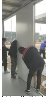
将第一块墙板插入已安装就位墙板，将顶部插入墙板，底部插入水槽槽口
