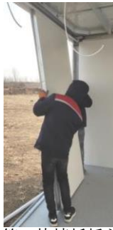
将第一块墙板插入已安装就位墙板，将顶部插入墙板，底部插入水槽槽口
